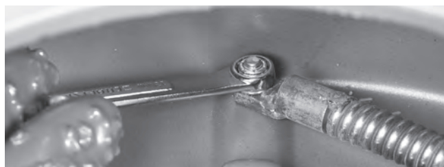
Figure 30 – Boulon de fixation de la queue de cochon
